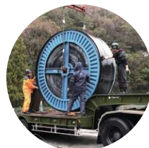
クレーン・リフトを利用しトレーラへ積み込み
